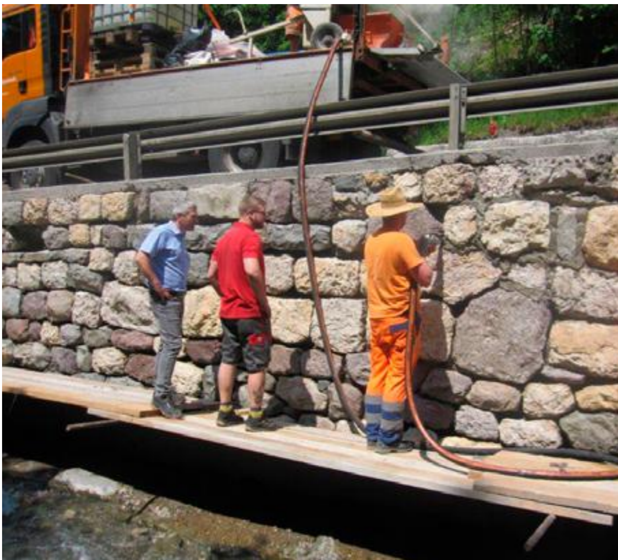
Arbeiten an einer Ufermauer durch die Mitarbeiter der Straßenmeisterei Wörgl
