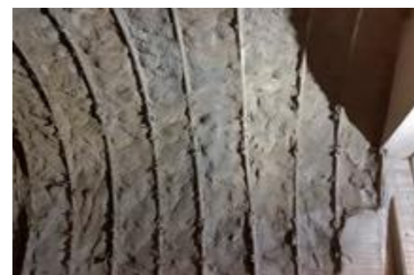
Spritzbetonsanierung
