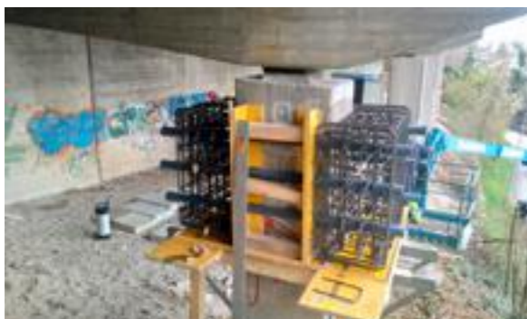
Bewehrung der Ankerblöcke
