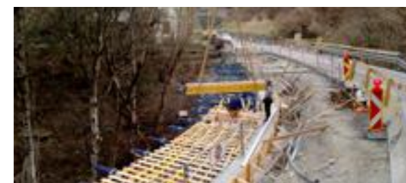
Schalungsarbeiten Hangbrücke
