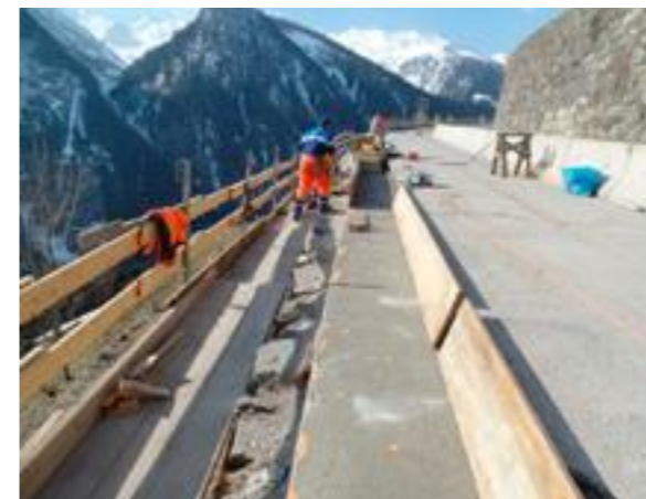
Erneuerung von Randbalken mit Leitschienenmontage durch die Straßenmeistereien im Baubezirksamt Lienz
