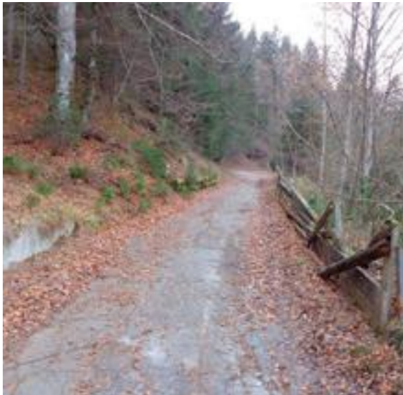
Baub Abschnitt vom Mittelbereich des Radweges vor dem Ausbau
