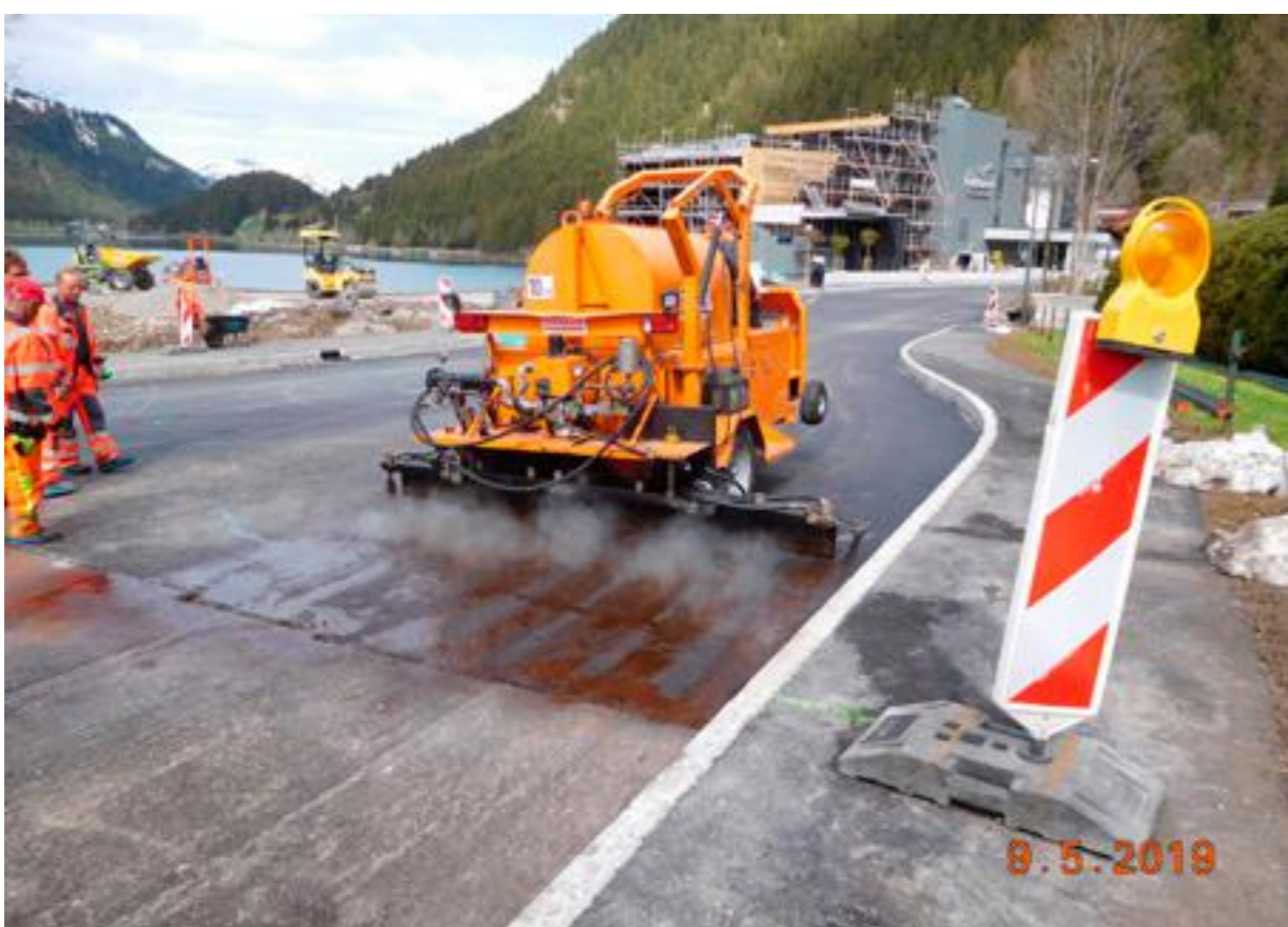
Vorspritzen der Bitumenemulsion beim Bauvorhaben B 199 Tannheimer Straße, km 9,88 – 10,35, Ortsdurchfahrt Haller
