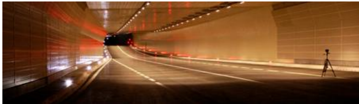
Unterflurtrasse Söll – Leuchtdichtemessung
