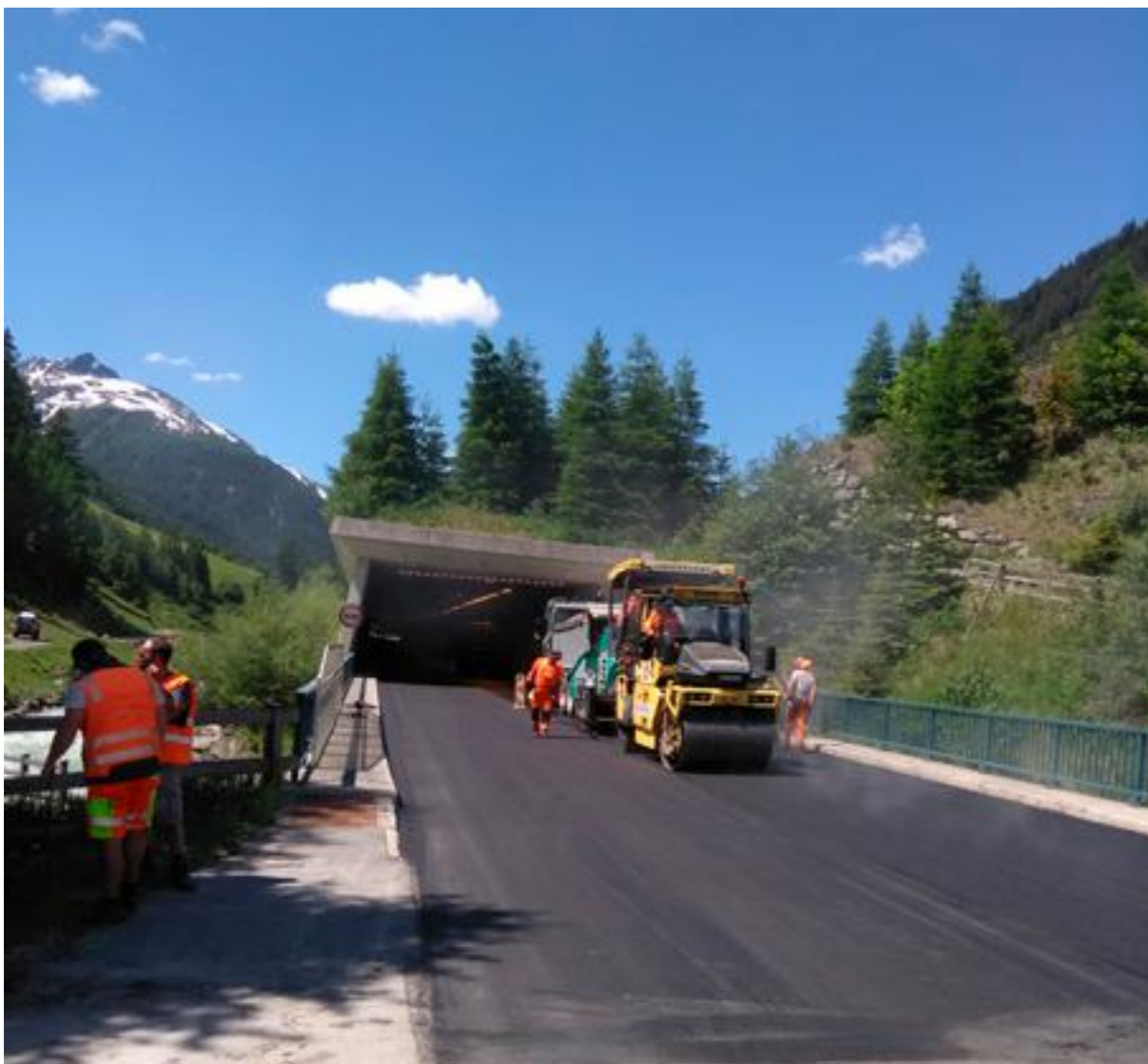
Belagsbauvorhaben im Bereich der Graf-Bärentalgalerie im Zuge der B 188 Paznauntalstraße, km 25,94 – km 26,98
