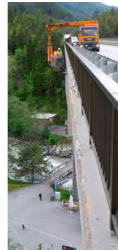
Brückenprüfung B 171, Ötztaler Talbrücke
