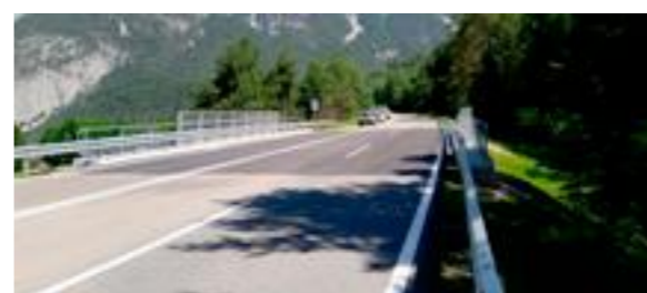
Nach Fertigstellung der Arbeiten
