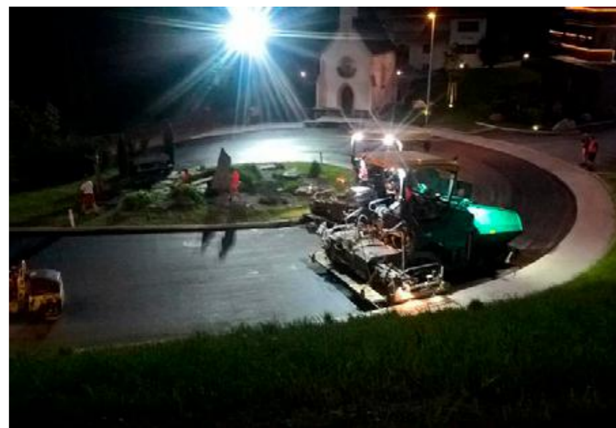
Nachteinbau beim Bauvorhaben L 6 Tuxer Straße, km 1,71 – km 1,88, Finkenberg Doppelkehre
