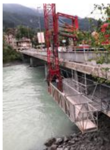
Einbau des Arbeitsgerüsts
