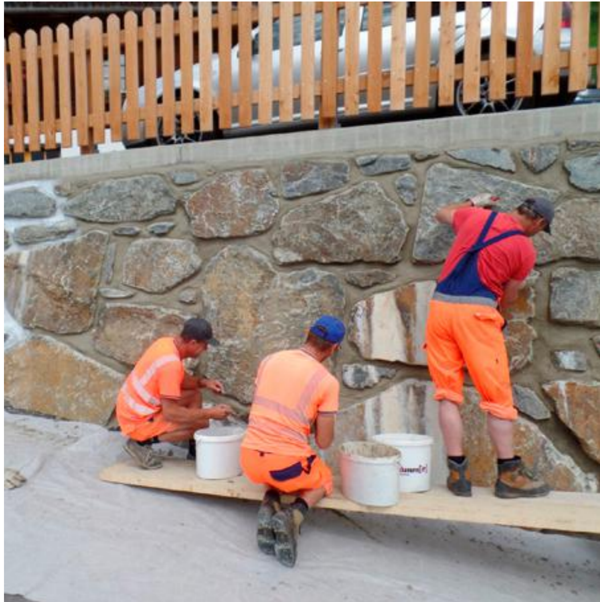
Sanierung einer Stützmauer in Osttirol
