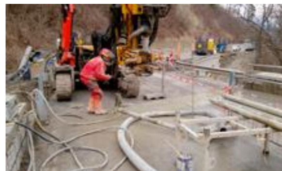
Erstellung der Mikropfähle
