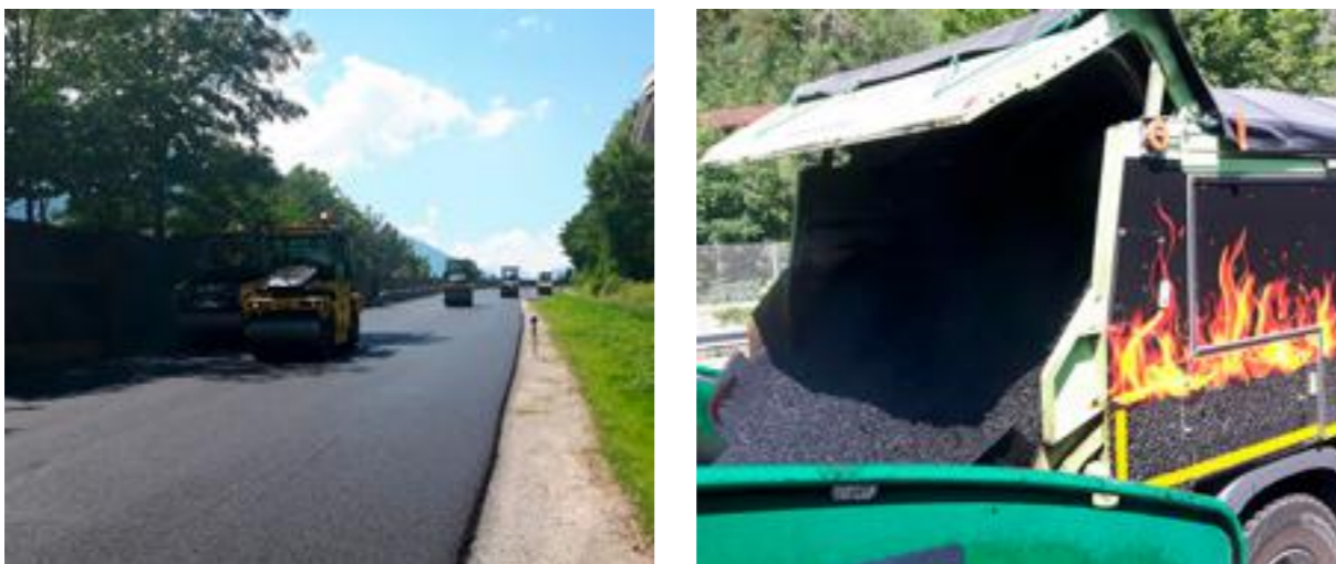
Walzeneinsatz und Nahtbehandlung beim Bauvorhaben B 177 Seefelder Straße, km 0,79 – km 2,40, Nordumfahrung Zirl
