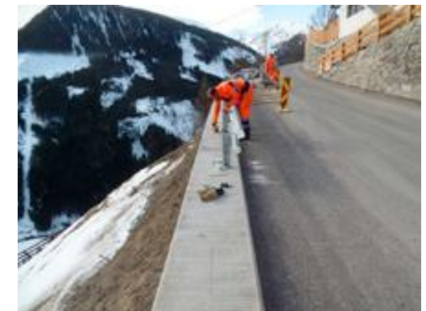
Erneuerung von Randbalken mit Leitschienenmontage durch die Straßenmeistereien im Baubezirksamt Lienz
