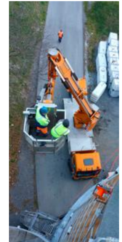
Siloprüfung B 182, Silo 57 Natters
