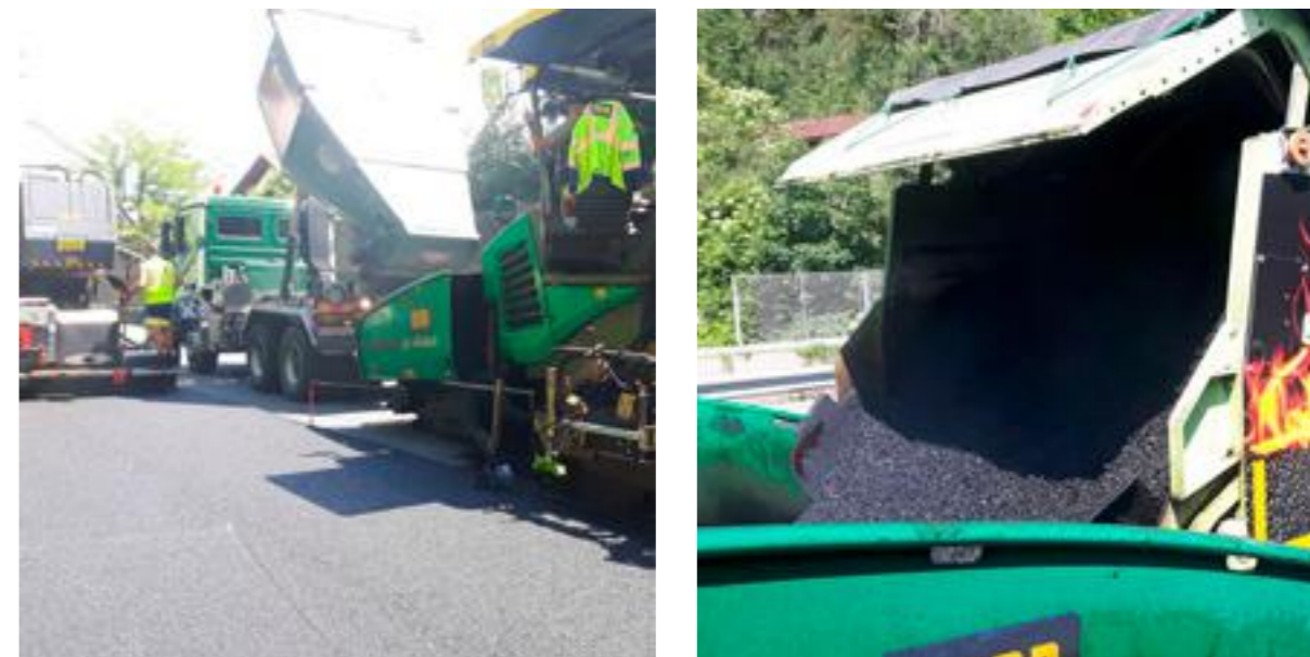
Nahtloser Einbau mit Schiebemulden beim Bauvorhaben B 177 Seefelder Straße, km 0,79 – km 2,40, Nordumfahrung Zirl
