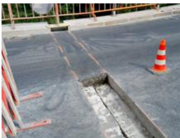
Arbeiten unter beengten Verkehrsverhältnissen
