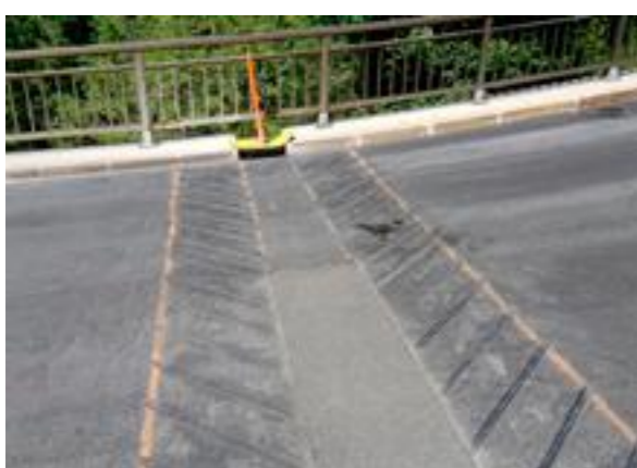
Erneuerung der Herdmauer
