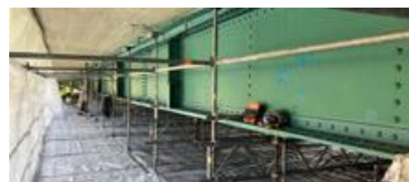
Staubdichte Einhausung des Tragwerkes
