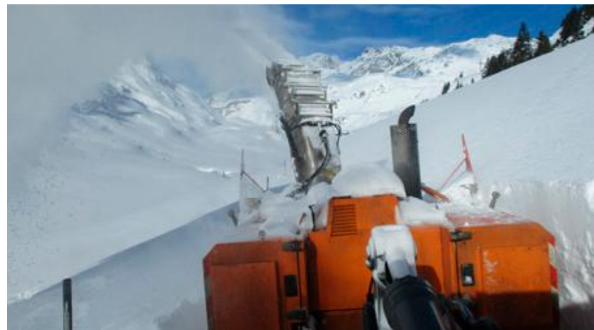
Einsatz einer Anbaufräse in St. Christoph am Arlberg durch die Straßenmeisterei Zams
