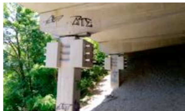
Ankerblöcke für Tragwerkshebung
