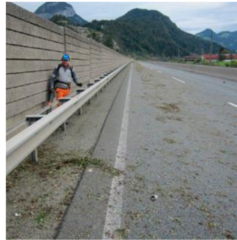
Instandhaltungsarbeiten an der B 178 Loferer Straße durch die Straßenmeisterei Wörgl
