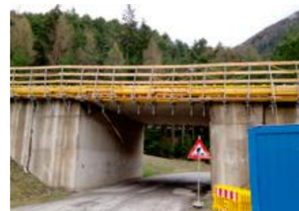
Einheben des Tragwerkes
