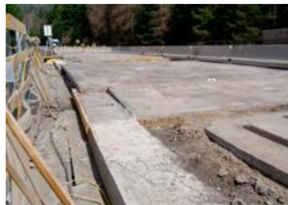
Abtrag alte Brücke
