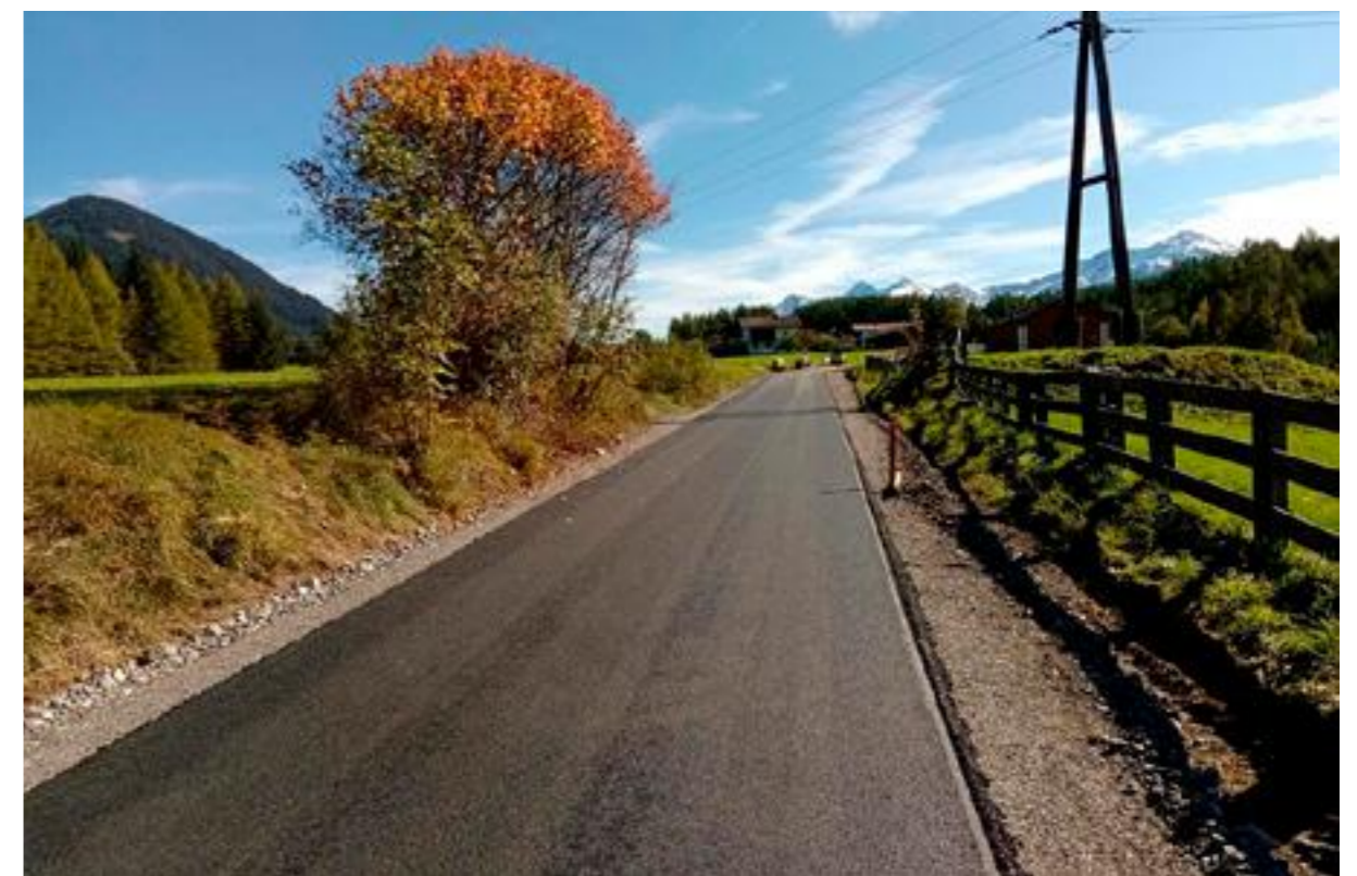
Baulosende Holzleiten nach dem Ausbau
