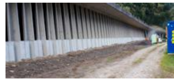
Erneuerung der Abdichtung
