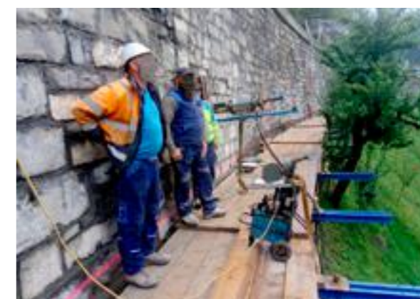
Ankerungsarbeiten
