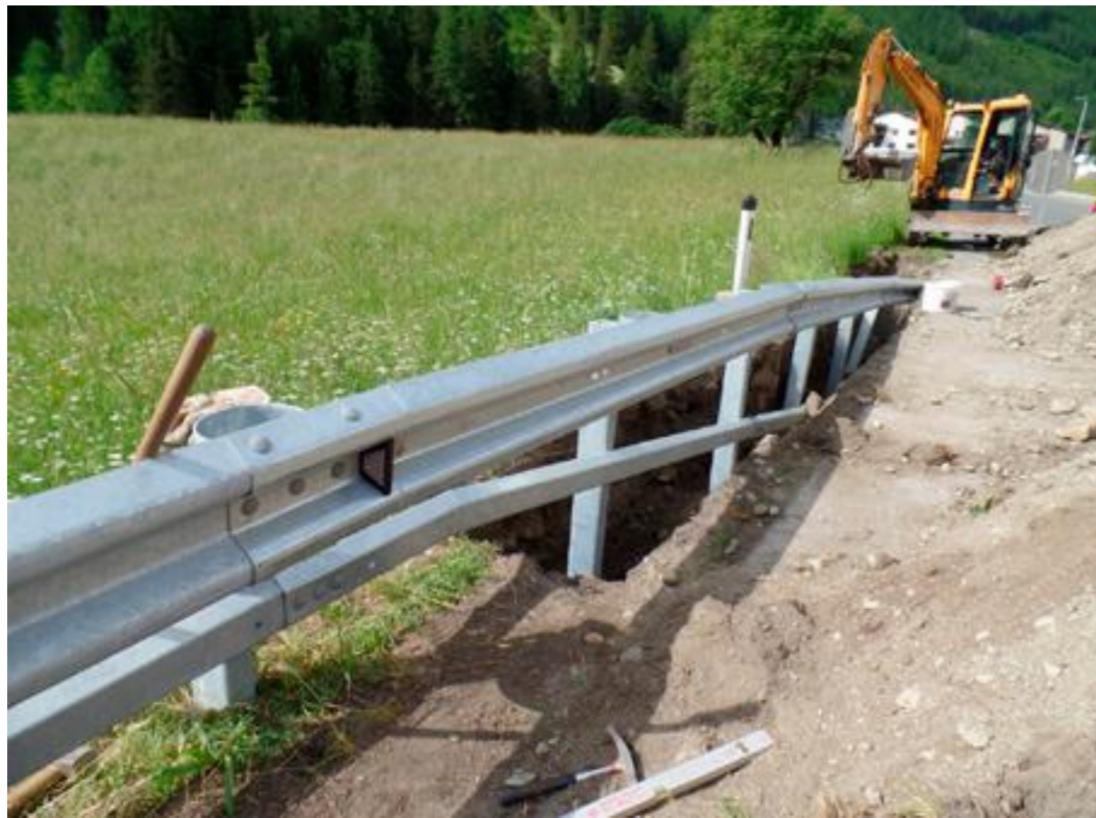
Einbau einer Leitschienenabsenkung zur Erhöhung der Verkehrssicherheit
