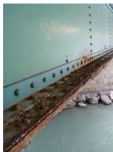
Korrosionsschäden
